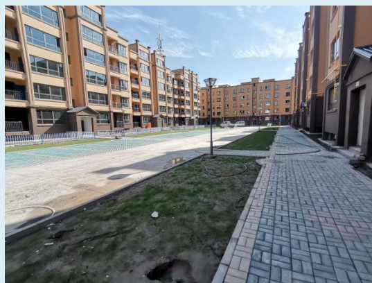
图 2.1-4 道路及硬化区的施工现状
